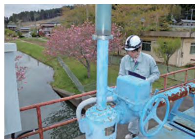
土地改良施設の診断
